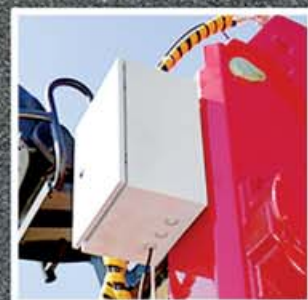
Электрический шкаф с оборудованием
