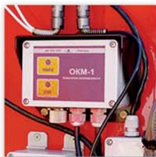
Электронный блок ограничителя предельного груза
