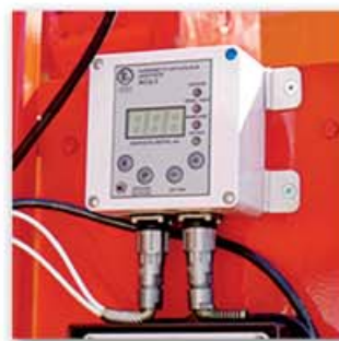
Электронный блок анемометра
