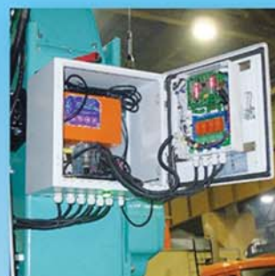
электрический шкаф с оборудованием
