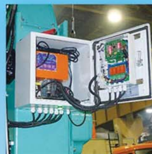
электрический шкаф с оборудованием
